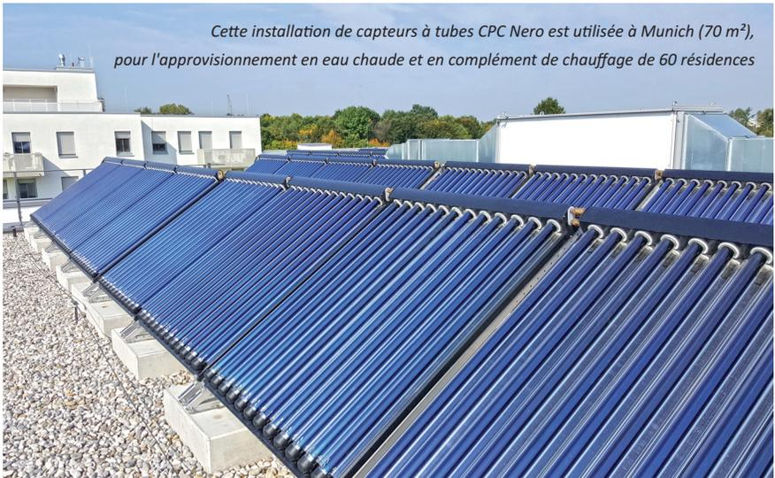
Cette installation de capteurs à tubes CPC Nero est utilisée à Munich (70 m<sup>2</sup>), pour l'approvisionnement en eau chaude et en complément de chauffage de 60 résidences
