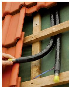
**Même dans les situations d'installation difficiles sous la construction du toit, l'installation est facile.**
